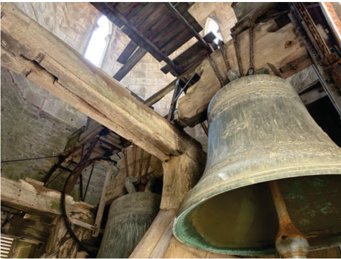
Vue de l'intérieur du beffroi.
